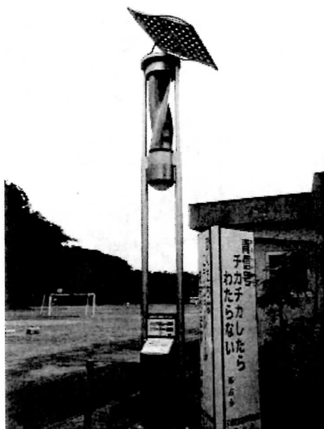
(館山市内にある小学校クロスフロー風力発電施設) ※設備規模 198W
