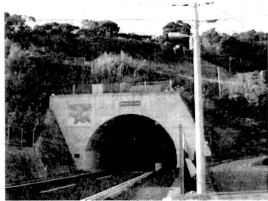
(安房三芳トンネル太陽光発電照明設備)
