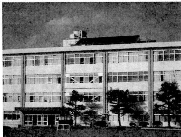
(屋上に太陽光モジュール設置)
